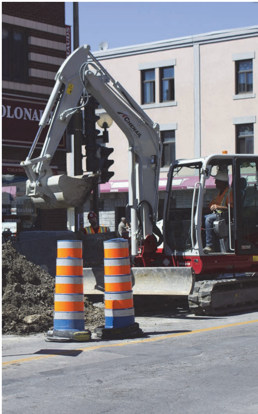
Travaux préparatoires au réaménagement de la rue Ontario Est
