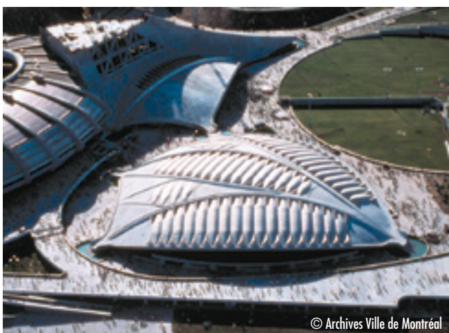
Stade Olympique et le vélodrome en construction 1976
