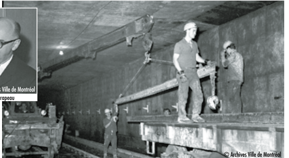
STM, pose des rails entre les rues Sherbrooke et Berri de Montigny, 05-08-1965
